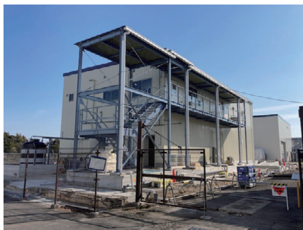
図 2 実証設備外観
