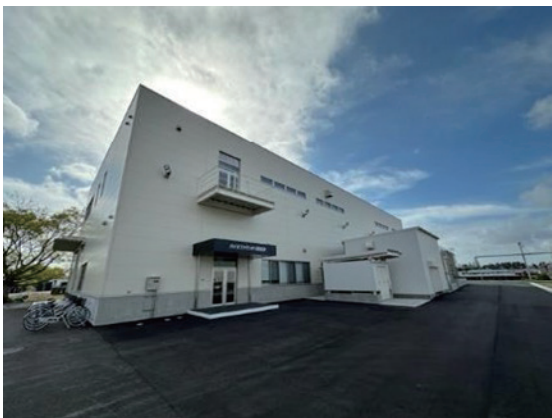
写真1 バイオフィアウンドリ研究所外観(千葉県茂原市)
