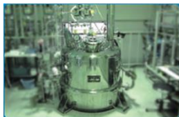
<バイオマスプラスチック製造設備>
